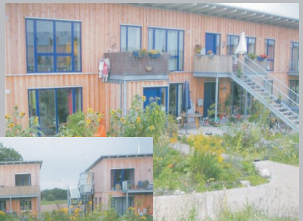
Nach der Fertigstellung
