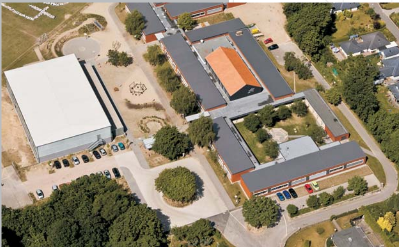
Luftbildaufnahme der Schule 1 Jahr nach Fertigstellung
