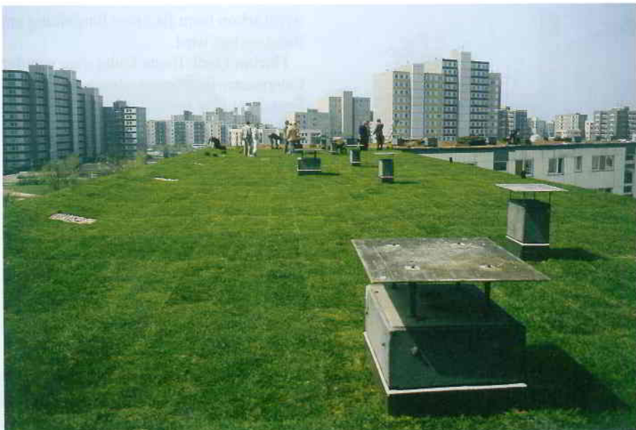
Die Kieler Wohnungsbaugesellschaft KWG wagte sich an das erste große Sanierungsprojekt mit Dachbegrünung: Kiel-Mettenhof 1985.
